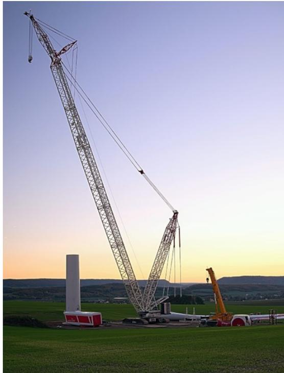
Figura 6.1.: Montagem de um aerogerador ou turbina eólica. Fonte: Pixabay.com
